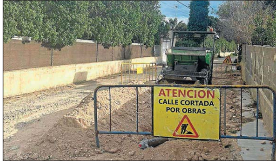
Obras en la urbanización El Romeral de Marines.
