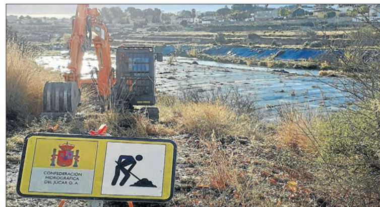
Treballs de preparació del terreny per a la plantació.
