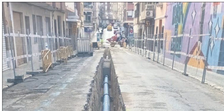
Obras en la red de abastecimiento en la calle San Miguel.
